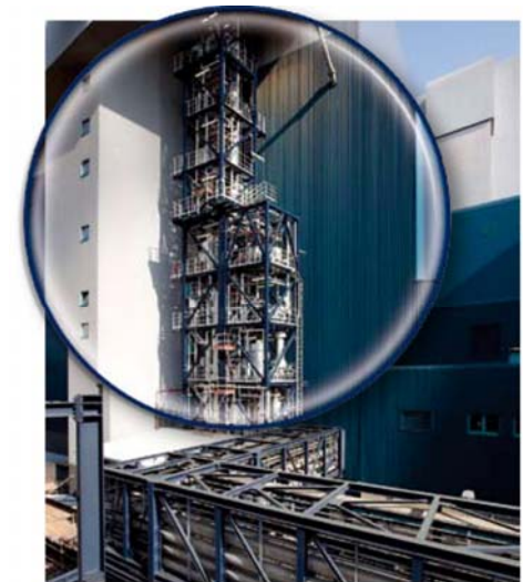
Die RWE-CO 2 -Wäsche-Pilotanlage in Bergheim-Niederaußem (Quelle: RWE)
